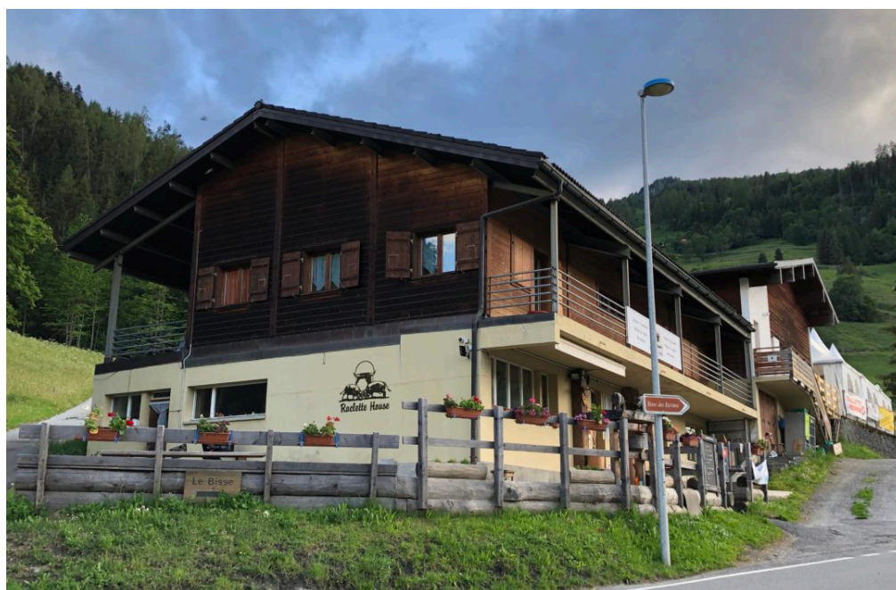
Maison de la Raclette. Source : https://quandestcequonmange.ch/racletthouse-chez-eddy-bruson-val-de-bagnes/
